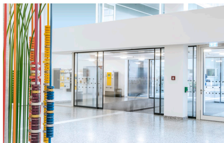
Filigrane Türprofile und in die Decke integrierte Slimdrive SLT-FR-Antriebe im Klinikum Stadtmitte in Stuttgart.
